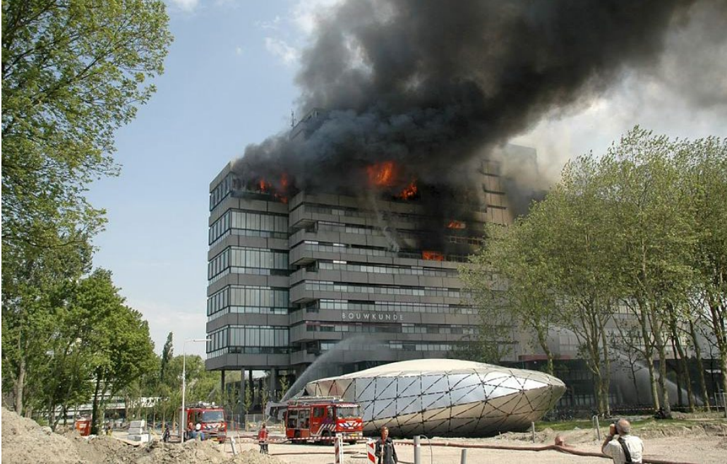
Figuur 5.3 Brand in hoogbouw (TU Delft)
